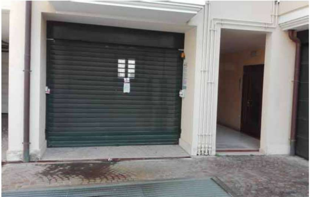
Foto 8 (Corte esterna ingresso piattaforma elevatrice garage)
