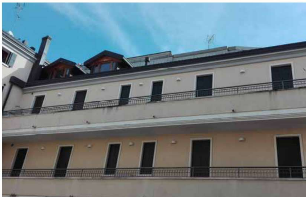
Foto 1 (Prospetto esterno lato ovest)
