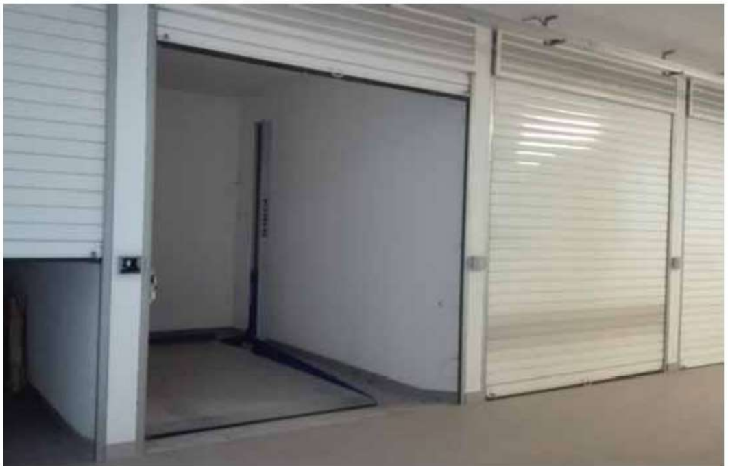
Foto 9 (Garage piano sottostrada)
