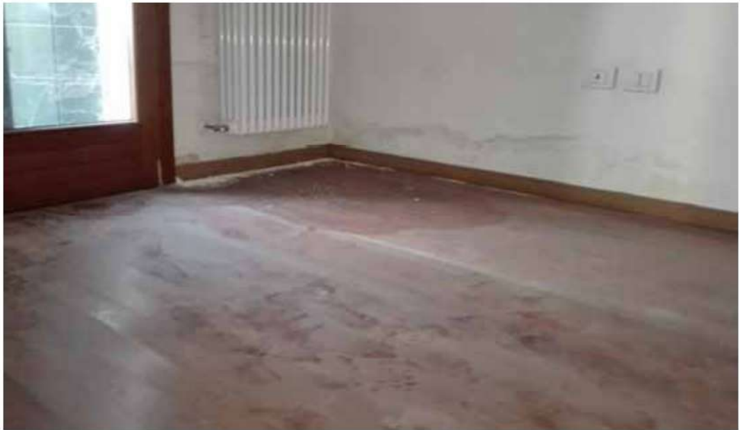
Foto 4 (Pavimentazione e muratura camera)
